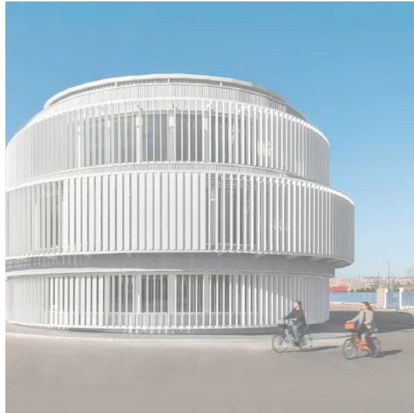
01 - CENTRO CONTROL AUVASA
